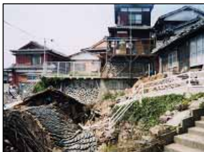
玄界島での集落の被災状況
