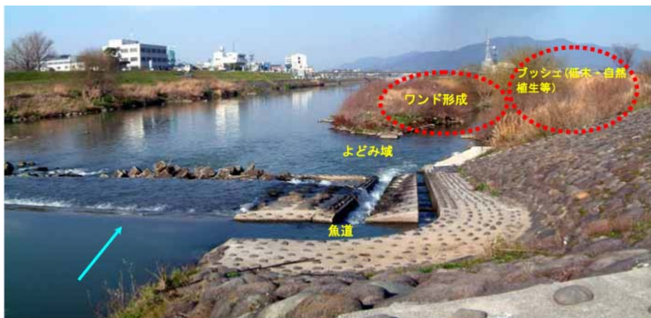
図IV-7：魚道及び整備状況の概況（平成15年）／新町床固（出典②）
