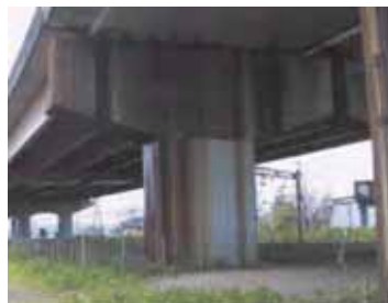
耐震補強により被災なし (新潟県中越地震)
