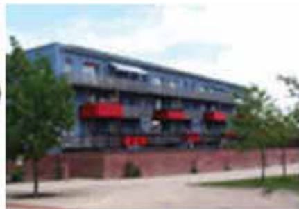
◆5階建てを3階建てに減築。外層デザインを一新し、テラス部分を増築、1階部には専用庭を設置。
