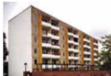
◆5階建てを3階建てに減築。外層デザインを一新し、テラス部分を増築、1階部には専用庭を設置。
