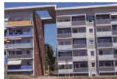
◆2棟の別々の建物の上に屋根を架けて通り抜けゲートとした
