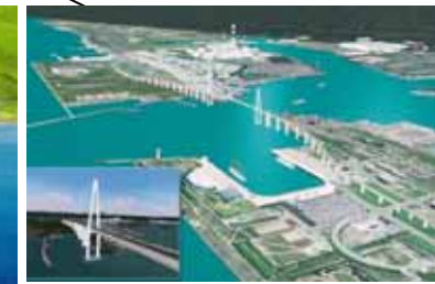
伏木富山港(新湊地区)・新湊大橋
