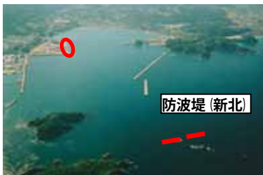
浜田港・多目的国際ターミナル
