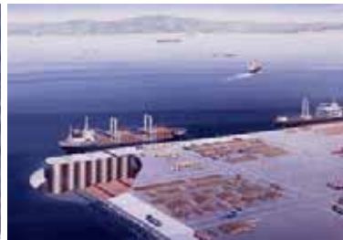
七尾港・多目的国際ターミナル
