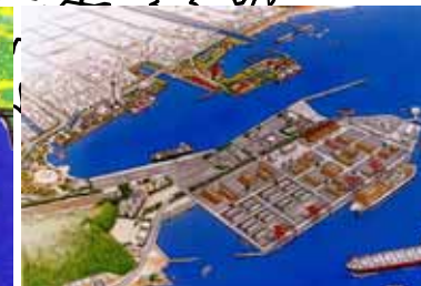
敦賀港・多目的国際ターミナル
