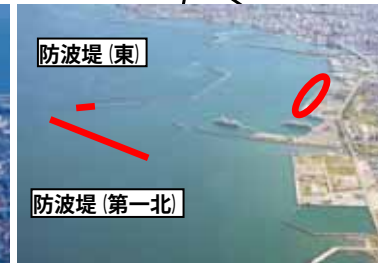
青森港・多目的国際ターミナル
