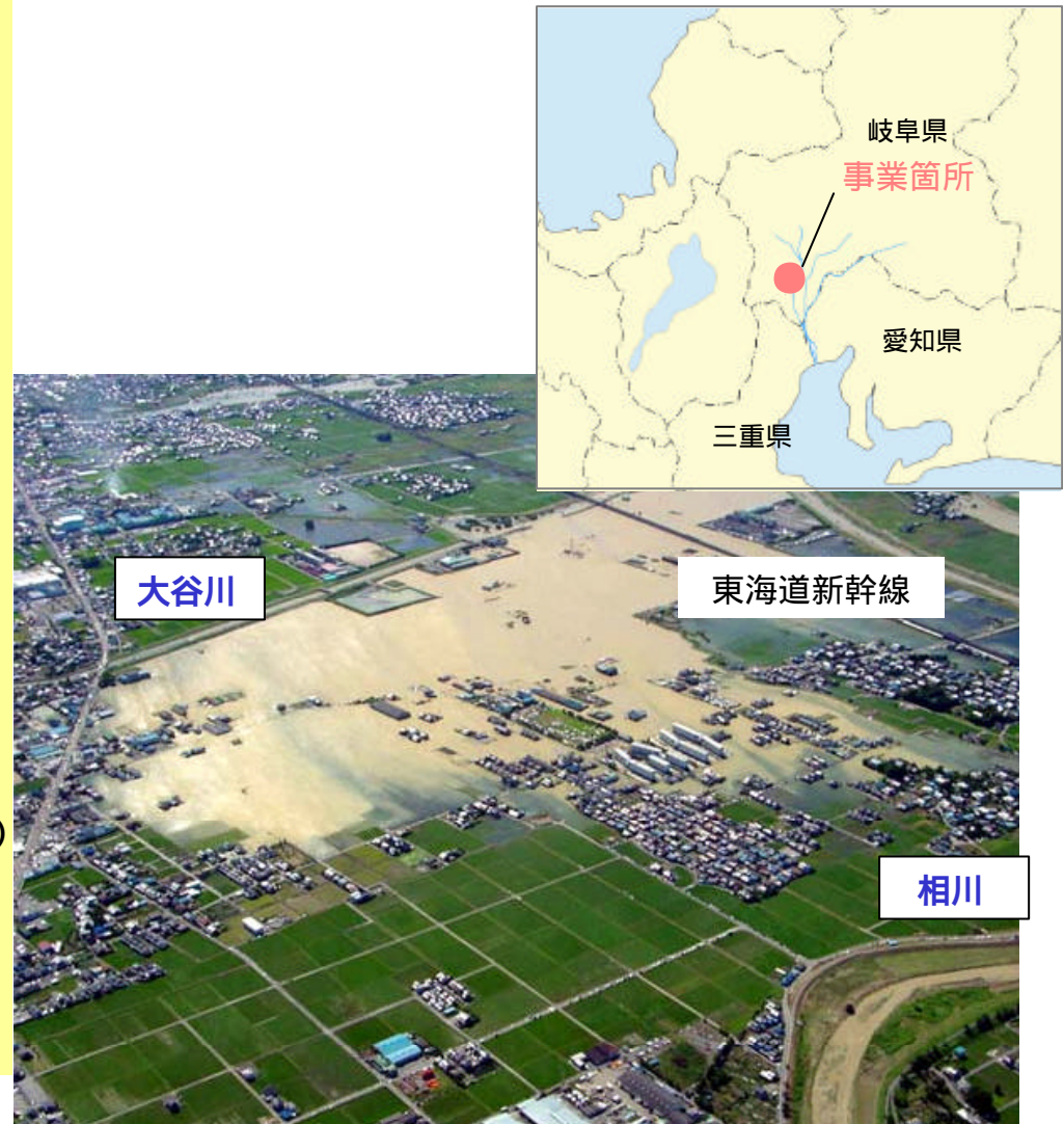
浸水被害状況
