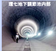
環七地下調節池内部
