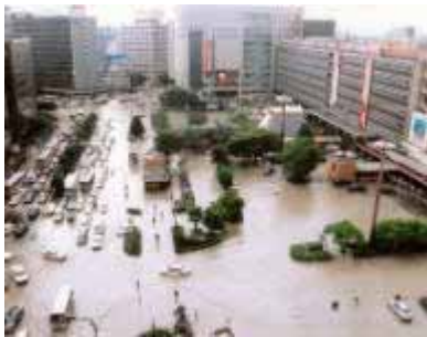
福岡水害(1999.6)博多駅周辺の浸水状況
