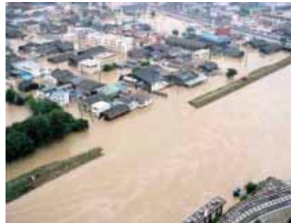
東海水害(2000.9)新川破堤状況
