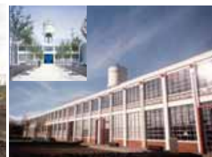
一期事業実施後(2002年)
