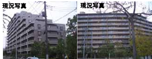
建築された集合住宅
