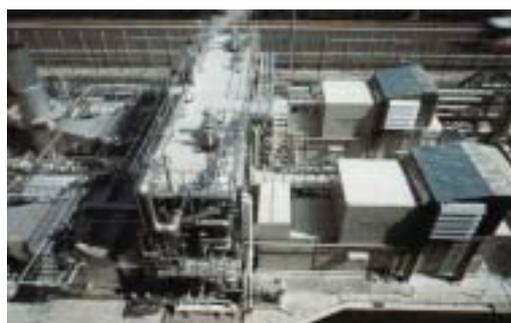
コージェネレーションシステム（1種類のエネルギーから電気や熱等を同時に発生させるシステム）を導入し、空港内の省エネ化を推進します
