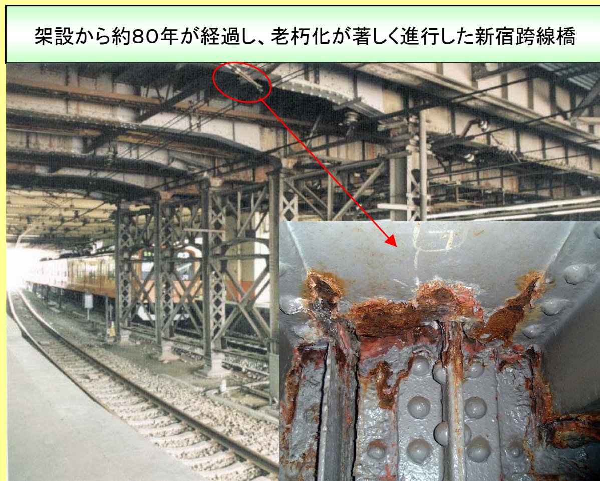
※新宿駅南口地区基盤整備事業の一環として、架替工事中
