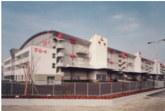
業務機能等を合わせ持つ 大阪港南港外貿Q-4上屋
