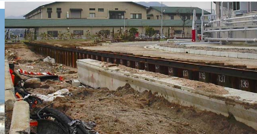
矢板の打設により仮復旧完了(10月13日)
