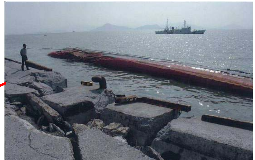
高波浪により貨物船が岸壁に衝突
