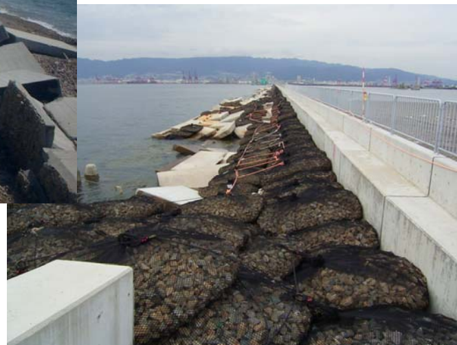
仮復旧完了(10月8日)
