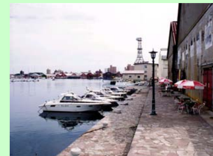
石積を再利用した物揚場
