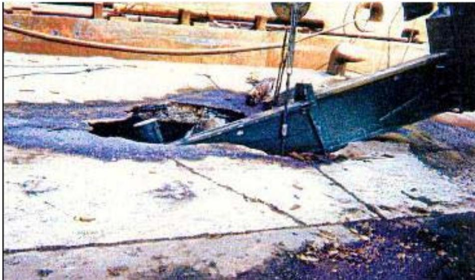
【岸壁エプロンの陥没により傾いたクレーン】
