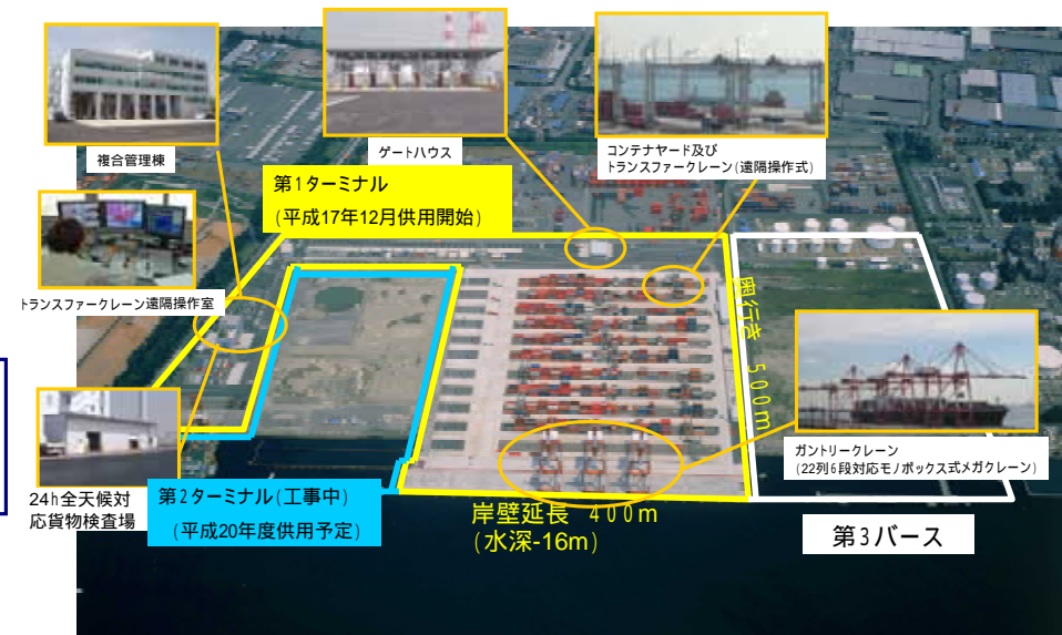
名古屋港飛島ふ頭南側コンテナターミナル
