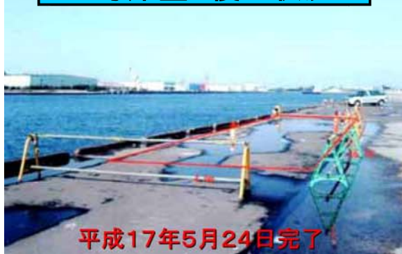
2号岸壁 復旧状況
