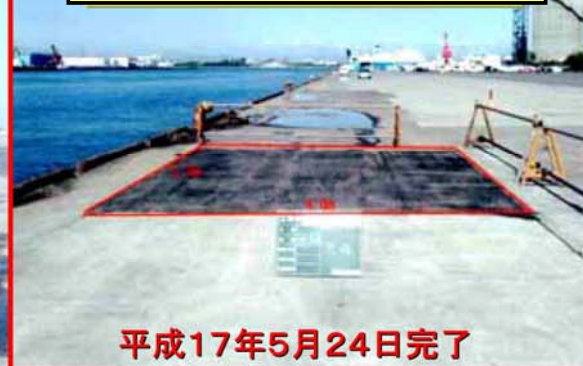
3号岸壁 復旧状況
