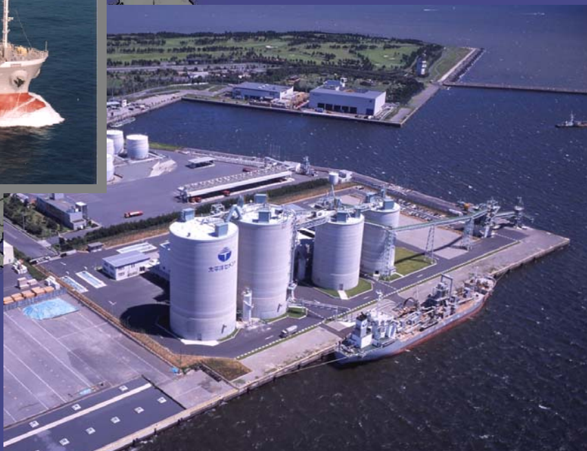
東京サービスステーション 貯蔵能力 65,000トン
