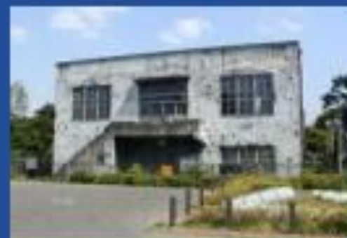
旧日立航空機株式会社変電所
