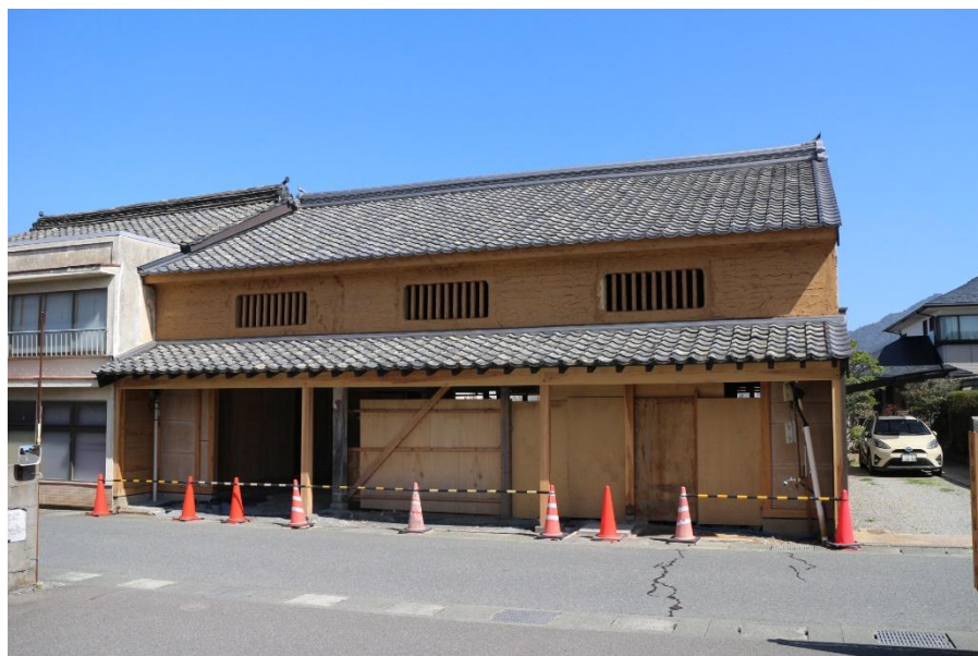
浜崎伝建地区町家モデル（旧松屋生花店） （令和4年3月、保存修理中のようす）
