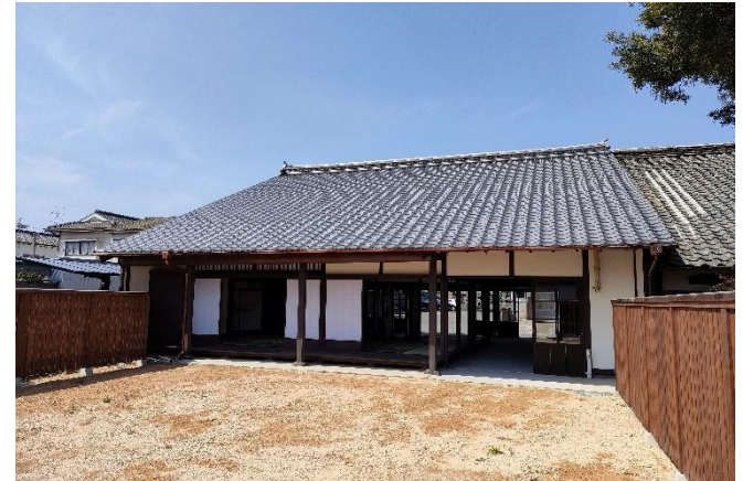
萩市による保存修理
