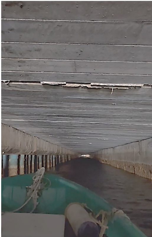
海上の狭い空間で目視点検を実施
