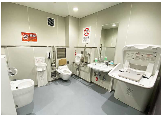
車椅子使用者用便房等（多機能トイレ）
