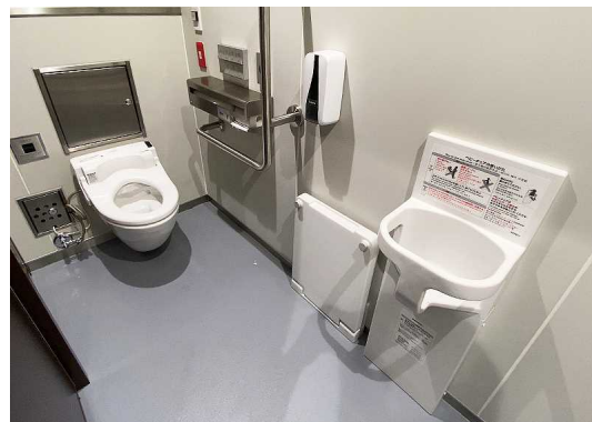
障害者等用設備が設置された一般便房
