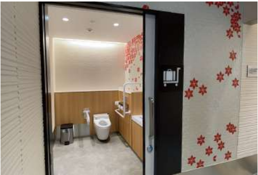
⑦カートのまま入れる便所（入口付近に設置）
