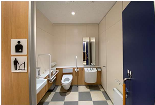
一般トイレのオストメイト用設備を設置した便房
