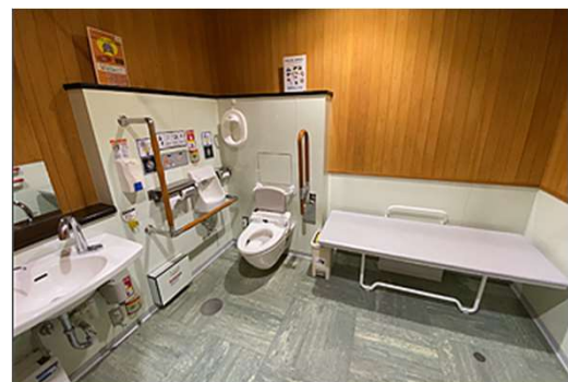
⑥車椅子使用者用便房等内の配置 (写真は静岡サービスエリア下り線のもの)
