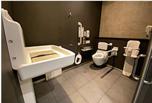
④一般トイレ内の車椅子対応便房
