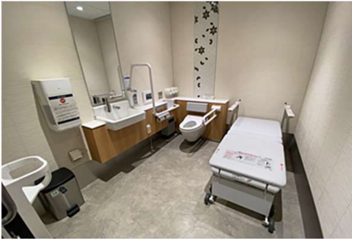
②車椅子使用者用便所等（右勝手） （オストメイト用設備を設置）
