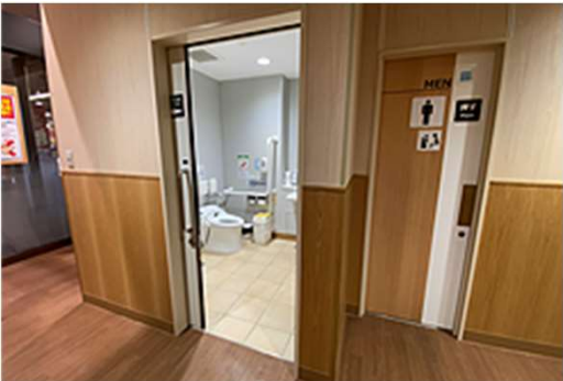
③車椅子使用者用便房等の出入口
