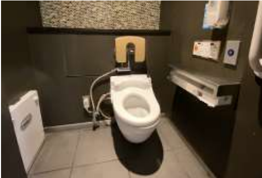
③一般トイレ内のオストメイト用簡易水栓設備
