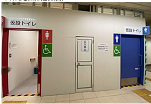
⑧トイレ工事中の車椅子対応仮設トイレ（写真は五橋駅のもの）
