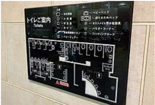
②トイレ出入口に設置された案内版（点字対応）
