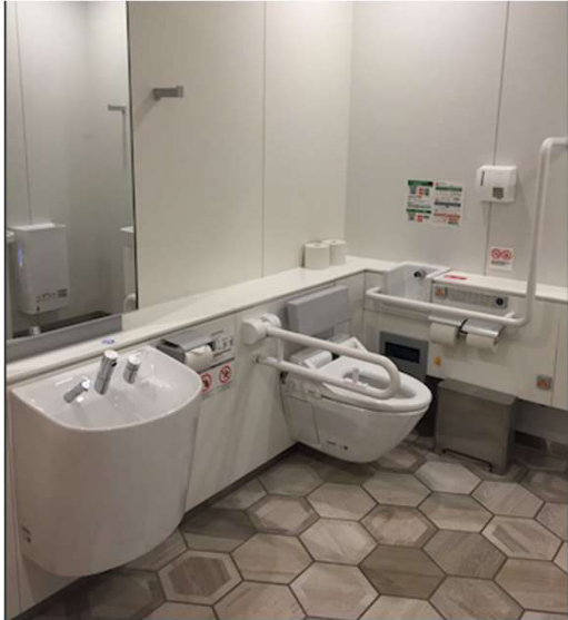
車椅子使用者用便房等（みんなのトイレ）の内部
