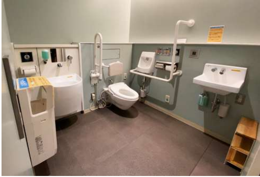
④ 車椅子使用者用便房等の内部
