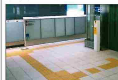
視覚障害者誘導用ブロック
