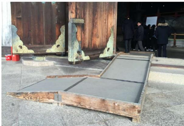
奈良県の東大寺では、車いすで通行可能とするため、参道の石畳の中央部を改修しているほか、大仏殿までのバリアフリールートが確保されています。寺社・仏閣は歴史建造物であることから、原状復旧が行えるよう、取り外し可能なスロープの設置等が行われています。
