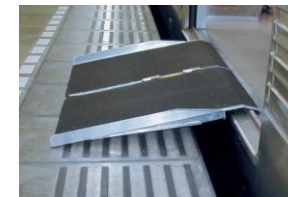
駅ホームにおけるスロープ板設置の例
