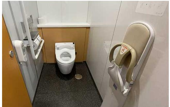
車椅子使用者用便房等（多機能トイレ）からの機能分散として、一般トイレにはオストメイト用設備、ベビーチェアを設置した車椅子使用者用簡易型便房を設置しているほか、他の便房にもベビーチェアを設置。一般の男女別トイレにおむつ交換台、女子トイレに小児用小便器も設置。
