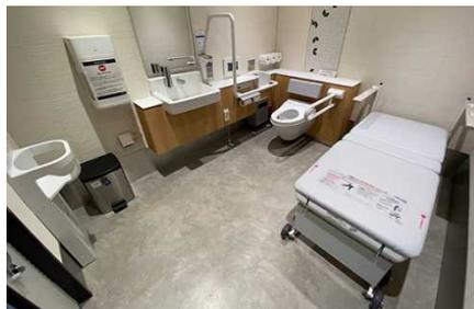
利き手や障害の状況により選択できるよう、左右勝手違いの車椅子使用者用便房等（多機能トイレ）を出入口付近に2か所設置。機能分散の観点から一方にはオストメイト用設備を設置していないが、車椅子使用者かつオストメイトの利用を想定してもう一方には設備を設置。
