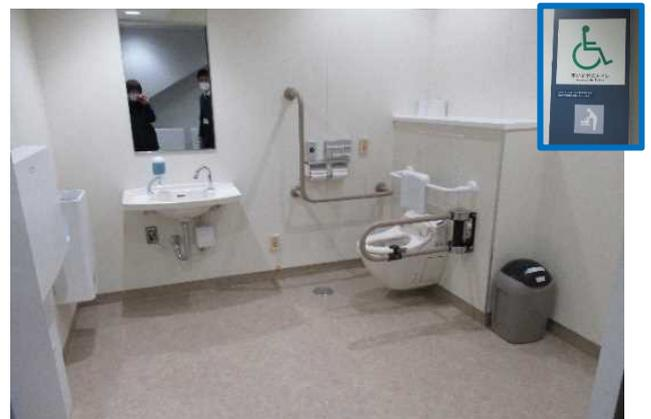
車椅子使用者用便房等（車椅子対応トイレ）は2種類あり、一方には大型ベッドとオストメイト用設備（汚物流し＋温水の出る水栓）、もう一方には乳幼児連れ用設備（おむつ交換台）が設置されている。
