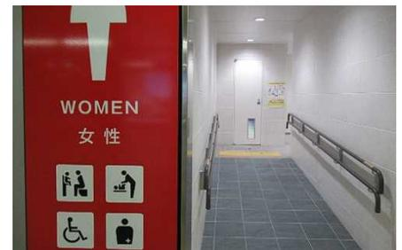
既存改修のため、配管の関係で段差解消が困難な場合は、スロープの設置により対応。
