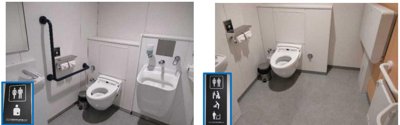
機能分散を図るため、オストメイト用設備（汚物流し+温水の出る水栓）が設置された便房及び乳幼児連れ用設備（おむつ交換台、ベビ-チェア、着替え台）が設置された便房を整備。
