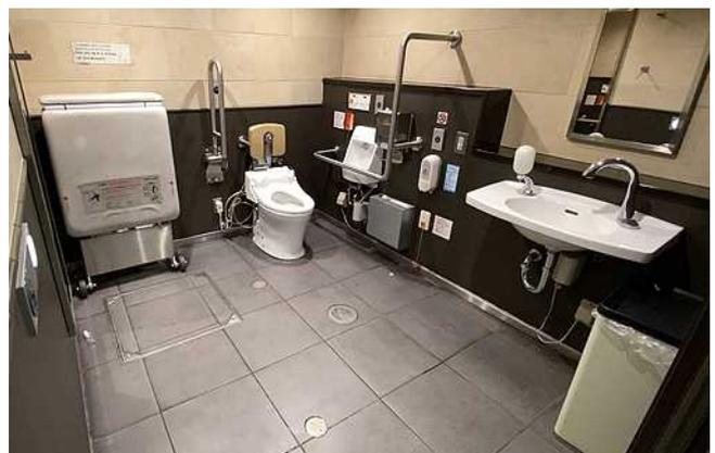
車椅子使用者用便房等（多機能トイレ）には、オストメイト用簡易水栓設備、大型ベッドを設置。なお、移動等円滑化整備ガイドライン（2018年版）以降の整備では、オストメイト用設備は汚物流しを設置。
