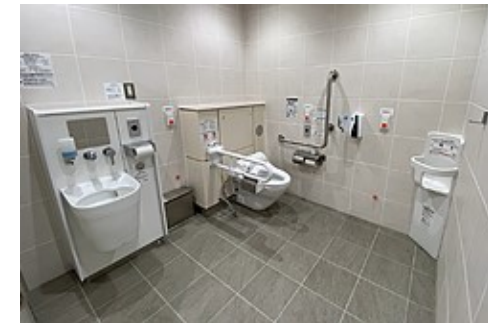
④一般トイレ内車椅子利用者用簡易型便房 (オストメイト対応)
