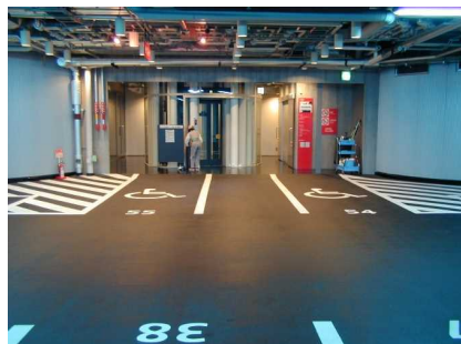
エレベーターホール前に設けられた車椅子使用者用駐車施設の例
