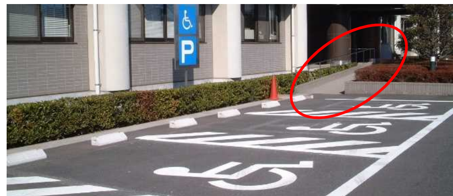
エントランスポーチの脇に設けられた車椅子使用者用駐車施設（ポーチまでスロープを設けている。）
