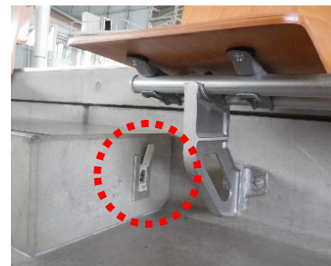
集団補聴設備の設置
