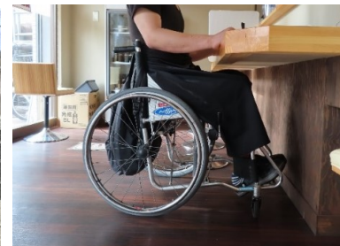
ローカウンターの設置
