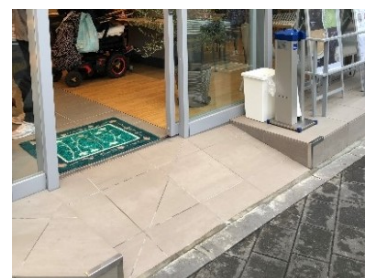
スロープの設置
