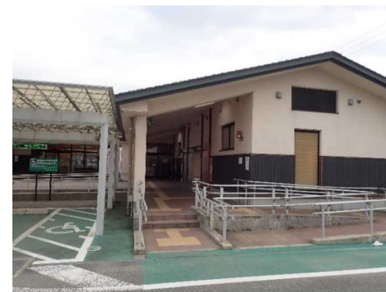
カラー舗装、スロープ設置
