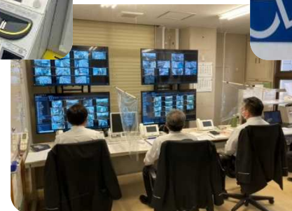
遠隔監視システム (西日本鉄道)
