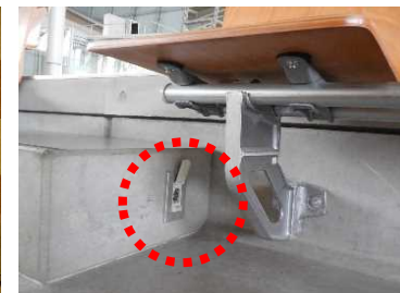
集団補聴設備の設置
