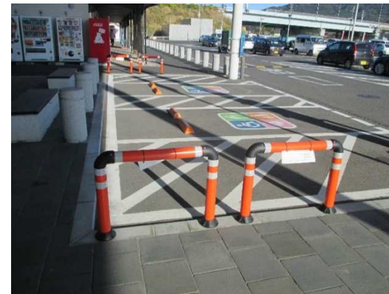
安全対策（バリカー）
