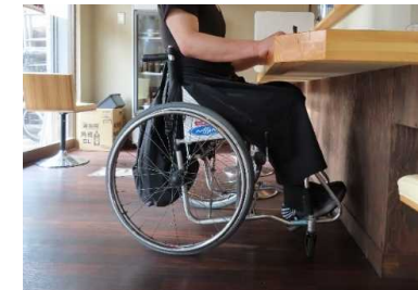
ローカウンターの設置
