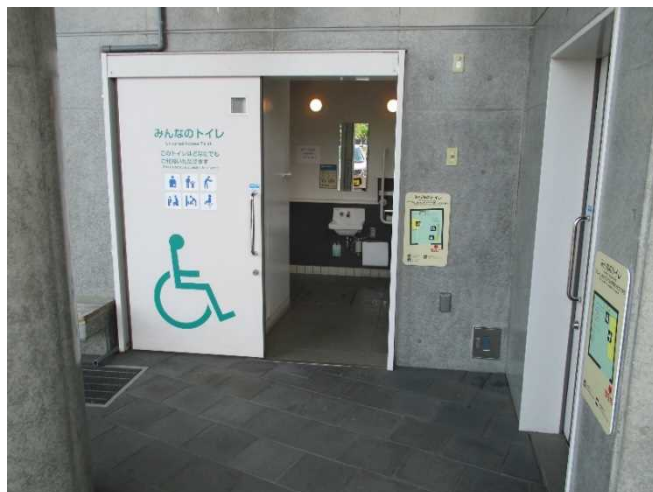
トイレ入口 （「道の駅」させぼくす 99）
