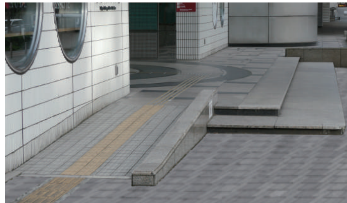
建物出入口のスロープ ①
