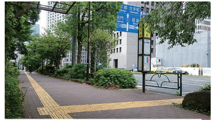
バス停までの経路を誘導する線状ブロック・点状ブロック
