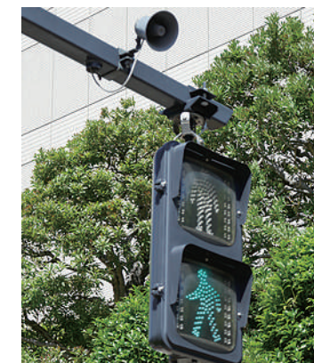
信号機(音声スピーカー)
