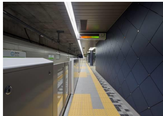
（緑葉師堂駅）ホームドア内側の乗降位置の明るさを確保した照明
