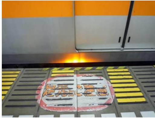
参考 3-1-10-5 : 回転灯等を設置して転落の危険に対し注意喚起している事例
