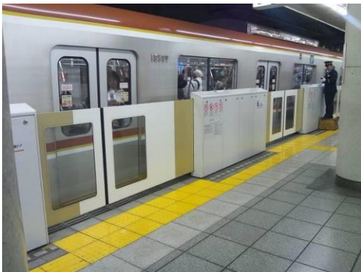
参考 3-1-6：可動式ホーム柵（昇降式）の例
