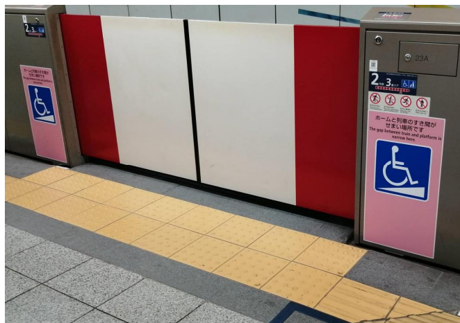
提供：東京地下鉄株式会社 丸ノ内線
