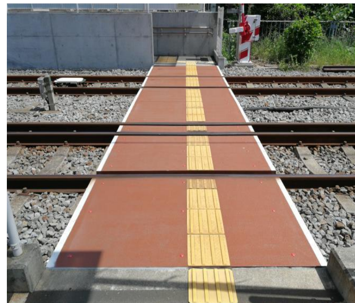
誘導ブロックの事例
