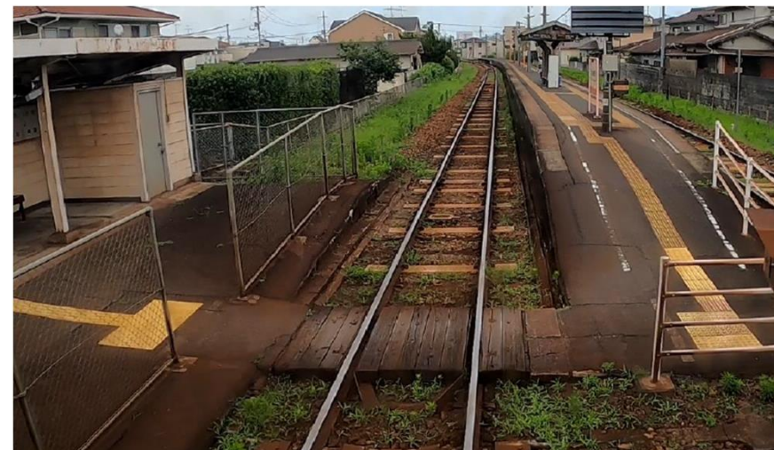
警告ブロック有の事例
