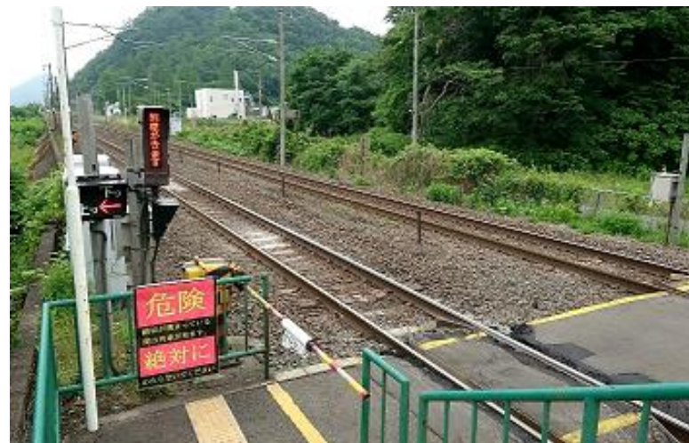
遮断かん有＋警報機無の事例
