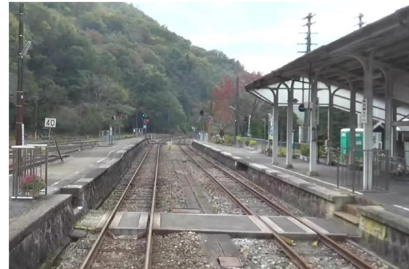
構内踏切直前まで段差がある事例
