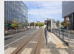
傾斜路の設置（富山電鉄 国際会議場前駅）
