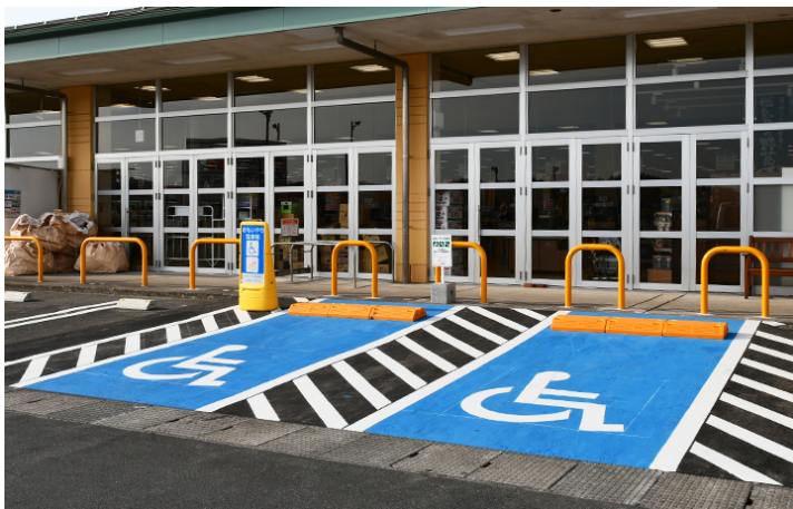
床面を青色に塗装した事例
