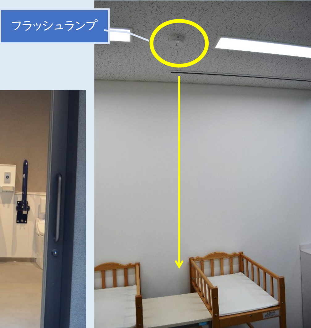
フラッシュランプをベッド位置から ずらして設置
