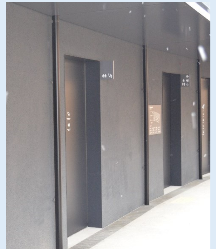
トイレ前通路(屋外回廊)
