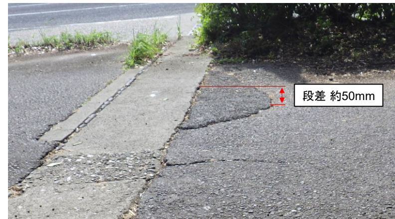
【新御園橋交差点付近】
