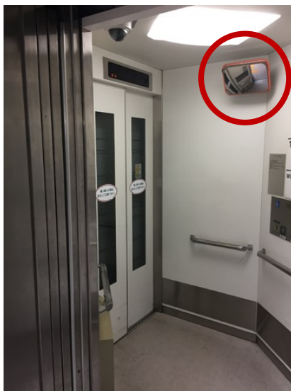
＜東京都交通局 板橋区役所前駅 直角二方向型エレベーター＞
