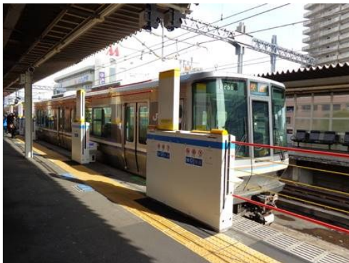
参考 3-1-6：可動式ホーム柵（昇降式）の例
