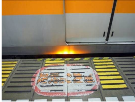
参考 3-1-10-5 : 回転灯等を設置して転落の危険に対し注意喚起している事例
