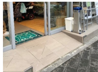
スロープの設置
