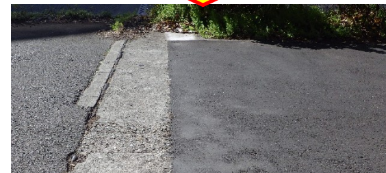
【新御園橋交差点付近】
