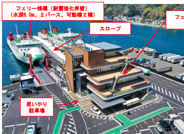
八幡浜港フェリーターミナル全景
