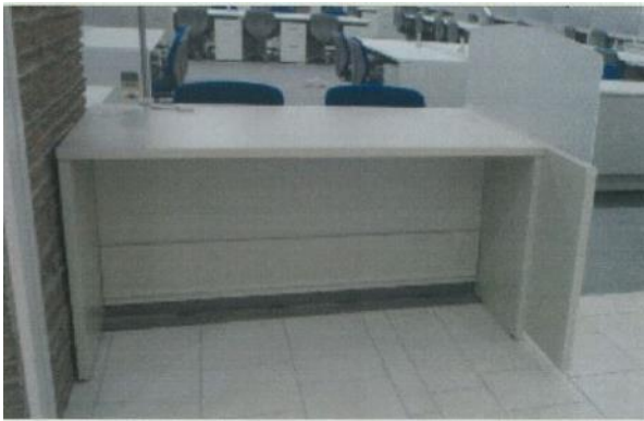
車いす使用者に対応している窓口カウンター
