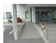
出入口の段差解消
