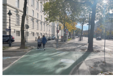
幅の広い歩道
