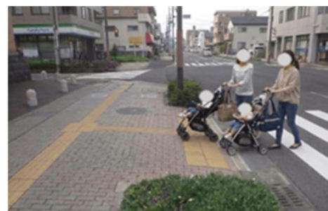
▲歩道と車道の段差解消
