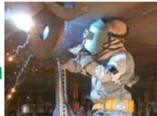
造船所での溶接作業
