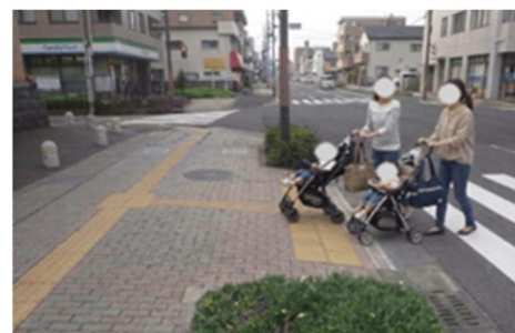
▲歩道と車道の段差解消
