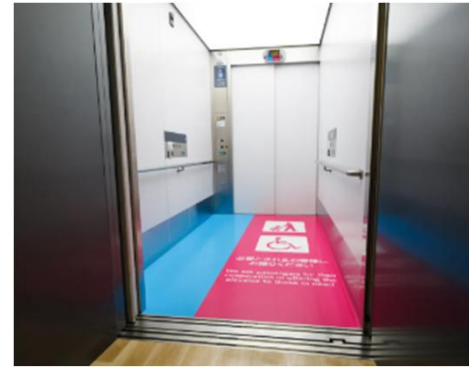
ベビーカーや車椅子のエリアを示す床サインを施したエレベーター (関西国際空港の取組)
