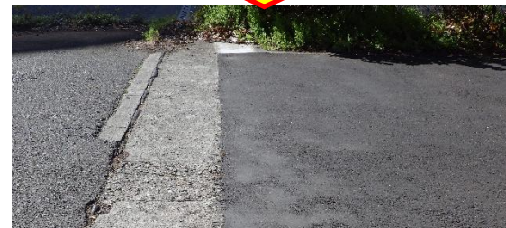
【新御園橋交差点付近】
