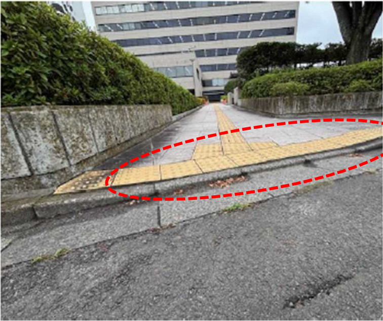
工事前の段差
